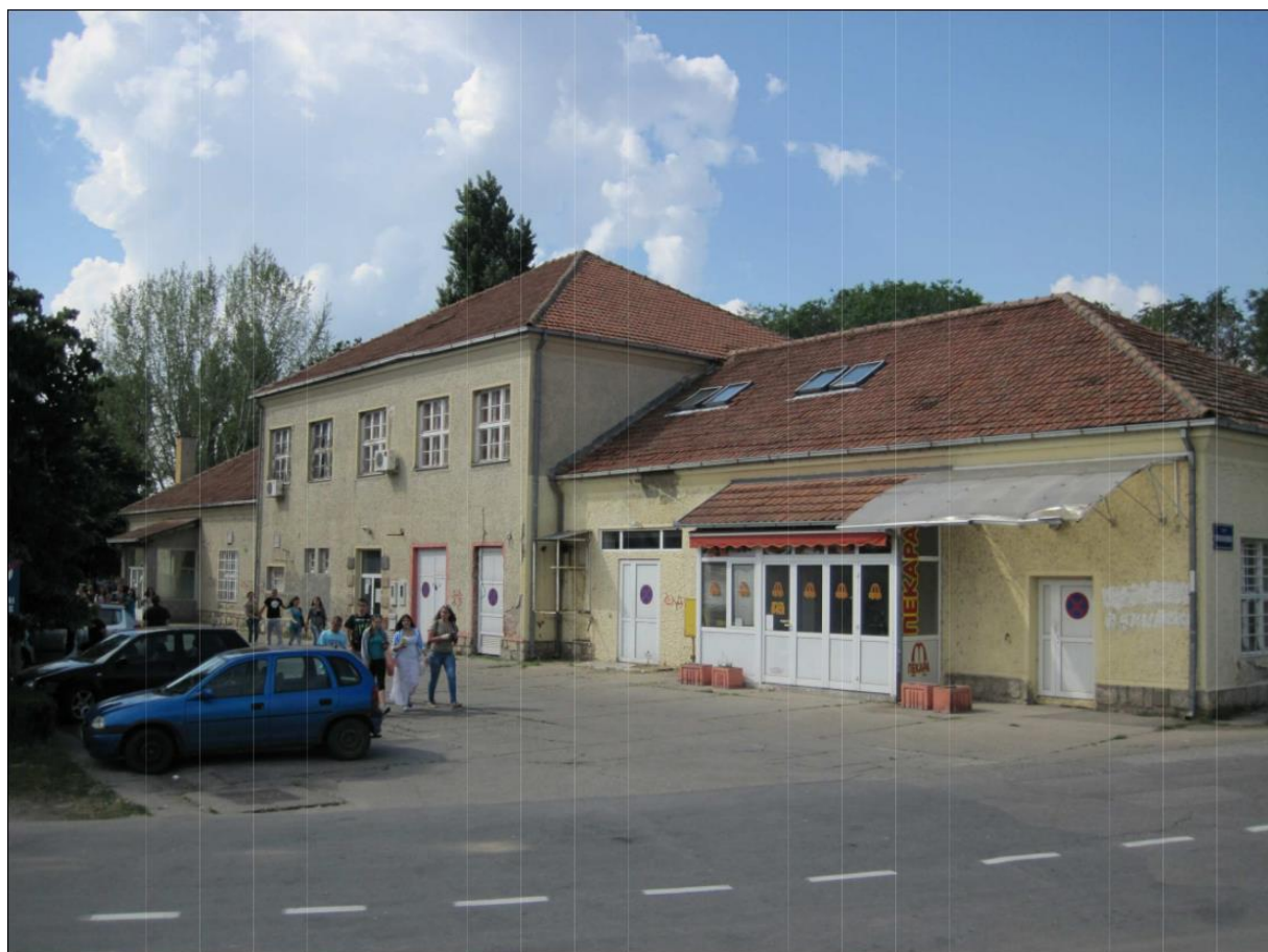
Поглед из Улице Патријарха Бранковића - постојеће стање
