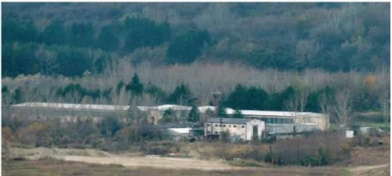
Слика 2.8. Део комплекса објеката Управе површинског копа Ћириковац.
