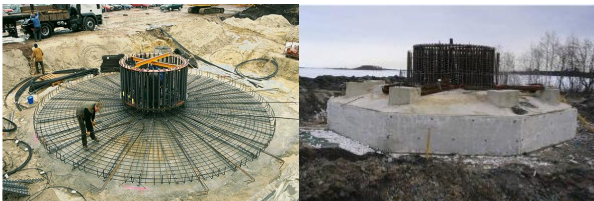
Слика 2.1. Примери темељења стубова ветротурбина
