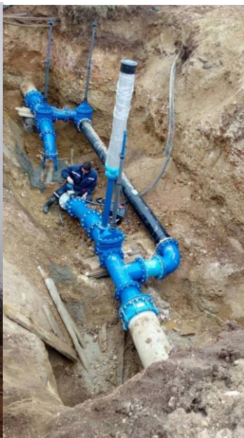
Уградње електромагнетних мерача протока у Параћину
