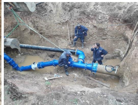
Уградње електромагнетних мерача протока у Параћину
