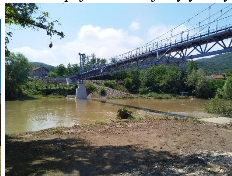
Трстеник- висећи мост преко Западне Мораве
