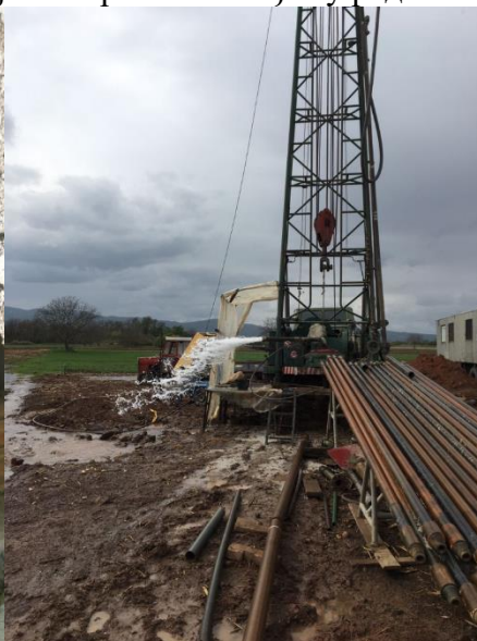
Радови на бушењу бунара Горуже 6
