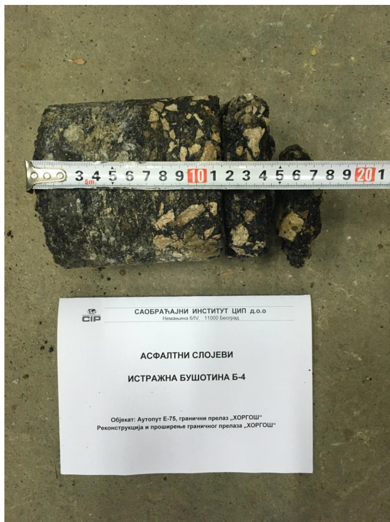
Слика П16.3 Узорак асфалтних слојева из бушотине Б – 4, km 0+970.27
