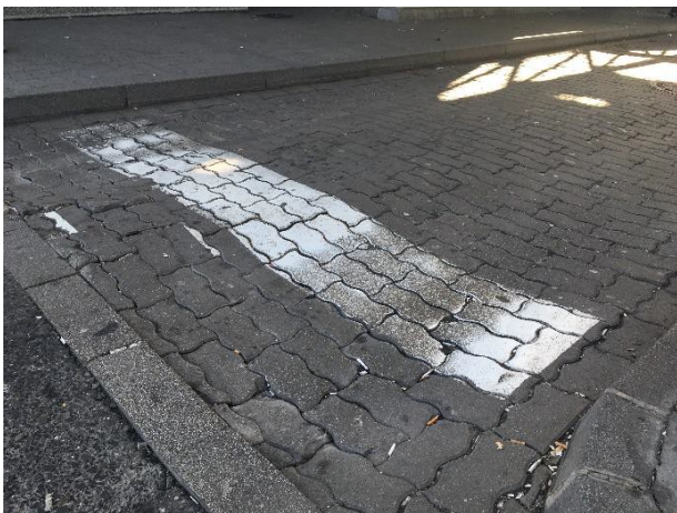
Слика 4.1.13. Колотрази на терминалу намењеном аутобуском саобраћају
