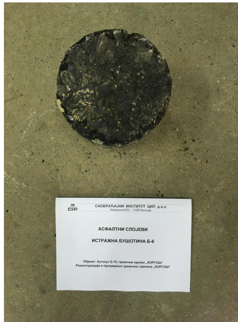
Слика П16.8 Горња површина узорка асфалтних слојева из бушотине Б – 6, km 0+423.02
