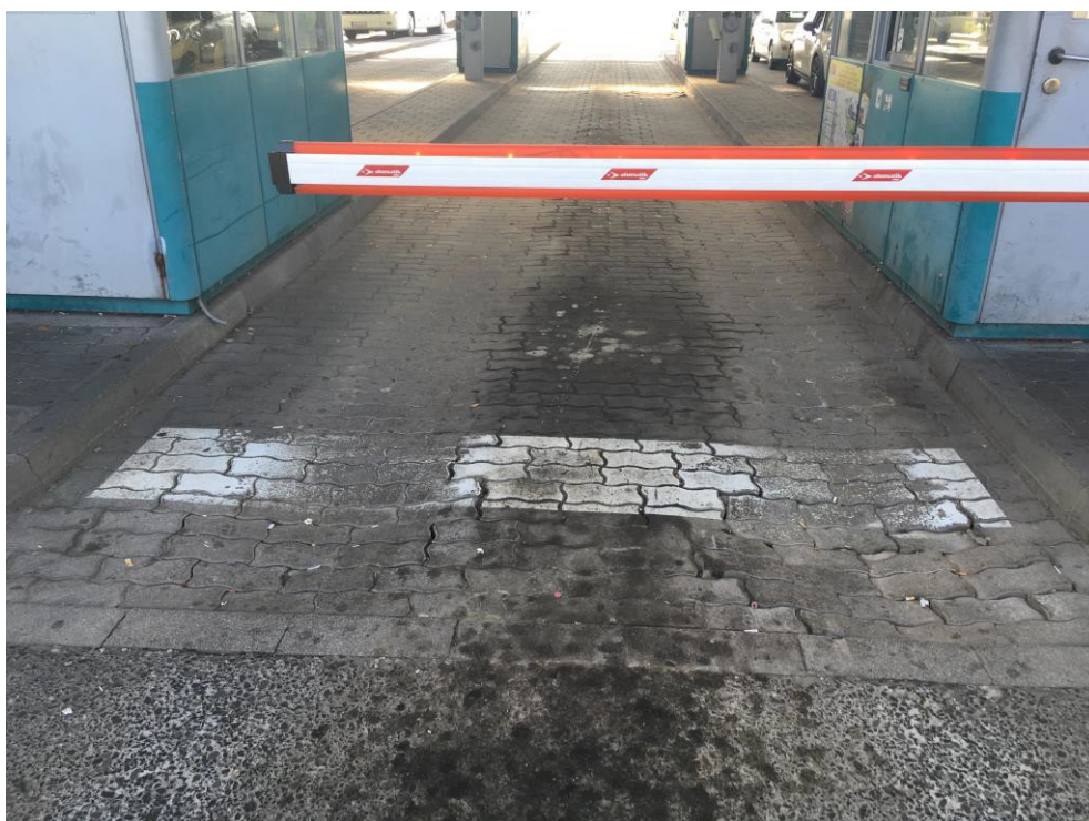
Слика 4.1.29. Колотрази на траци за путничка возила
