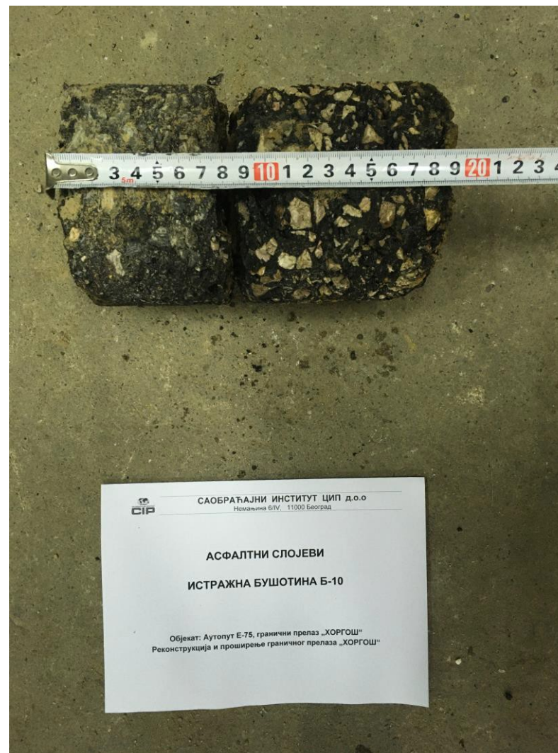
Слика П16.10 Узорак асфалтних слојева из бушотине Б – 10, km 0+296.49
