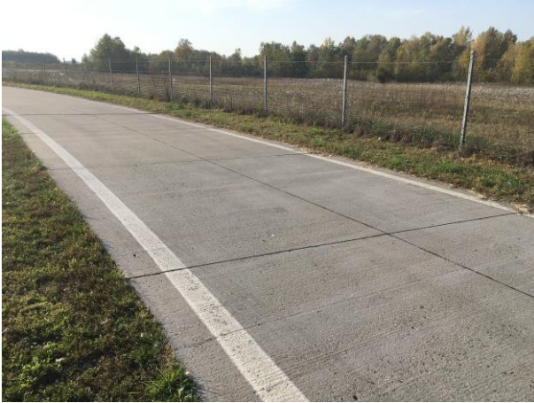
Слика 4.1.20. Постојећи бетонски коловоз на теретном терминалу
