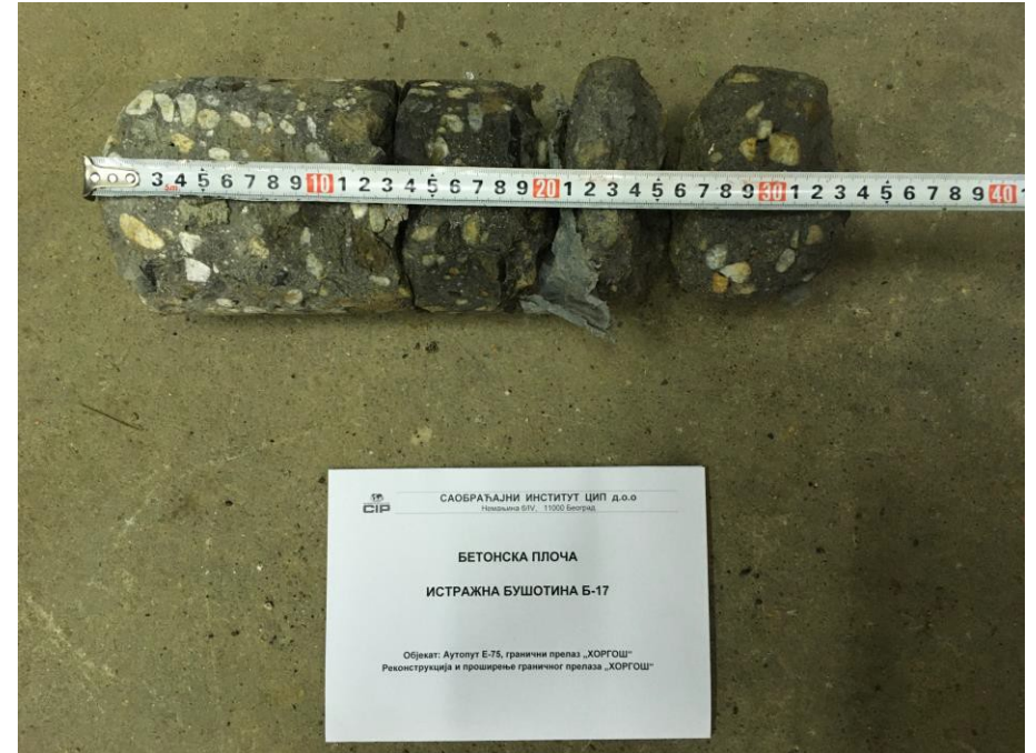
Слика П16.16 Узорак бетонског застора из бушотине Б – 17, km 0+366.40
