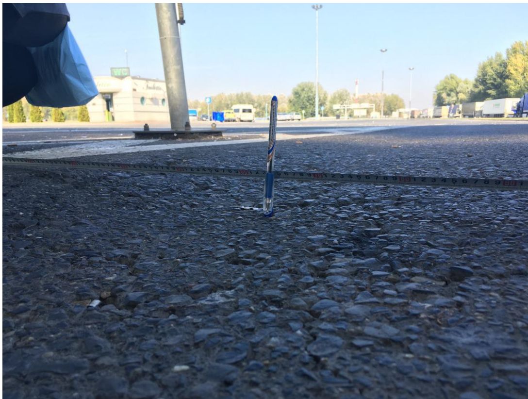
Слика 4.1.8. Колотрази у зони царинско - пасошке контроле
