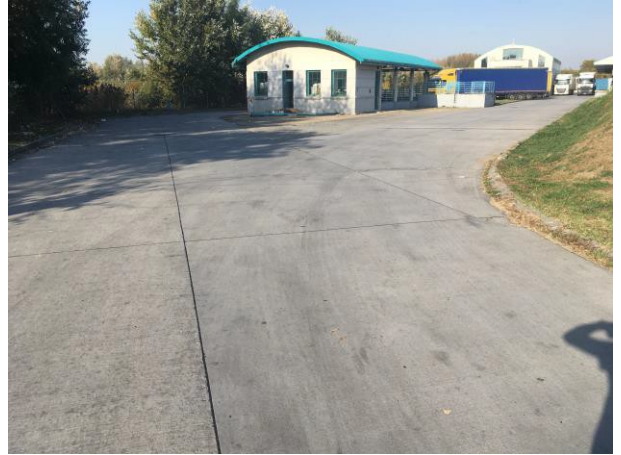
Слика 4.1.21. Постојећи бетонски коловоз на теретном терминалу
