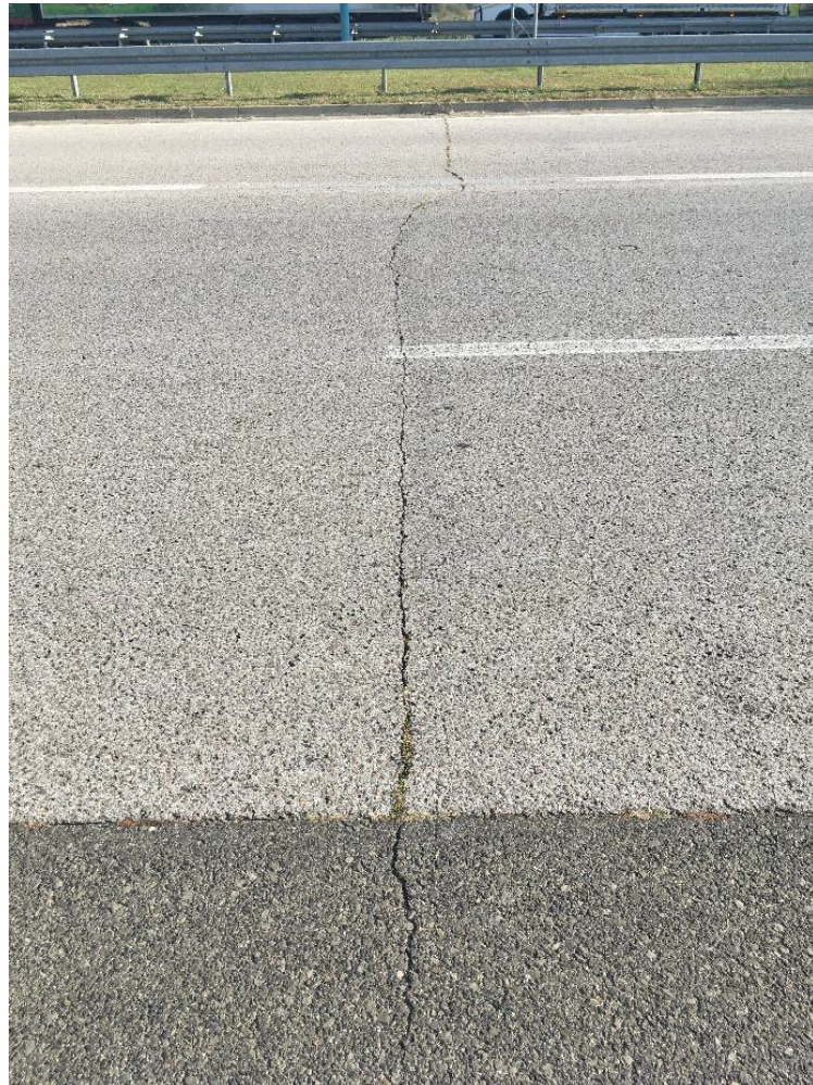
Слика 4.1.33. Попречна пукотина
