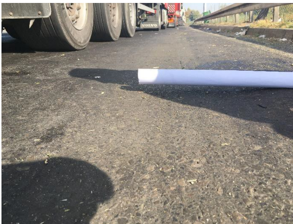
Слика 4.1.3. Колотрази на траци намењеној саобраћају теретних возила
