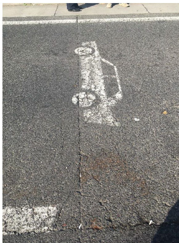
Слика 4.1.7. Попречна пукотина – радни спој
