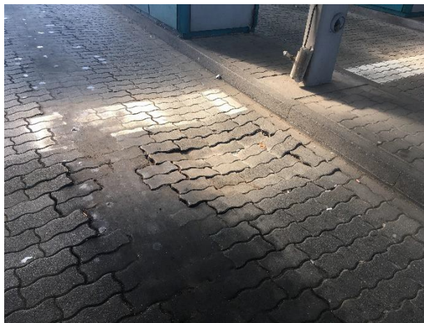
Слика 4.1.14. Улегнуће на терминалу за путничка возила. Плоче су улегле, одвојене и „лабаве“
