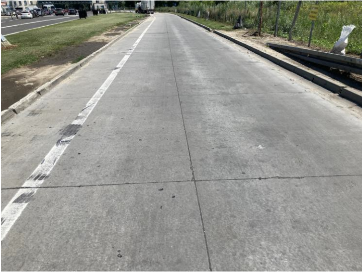
Слика 4.1.9. Бетонска плоча без оштећења
