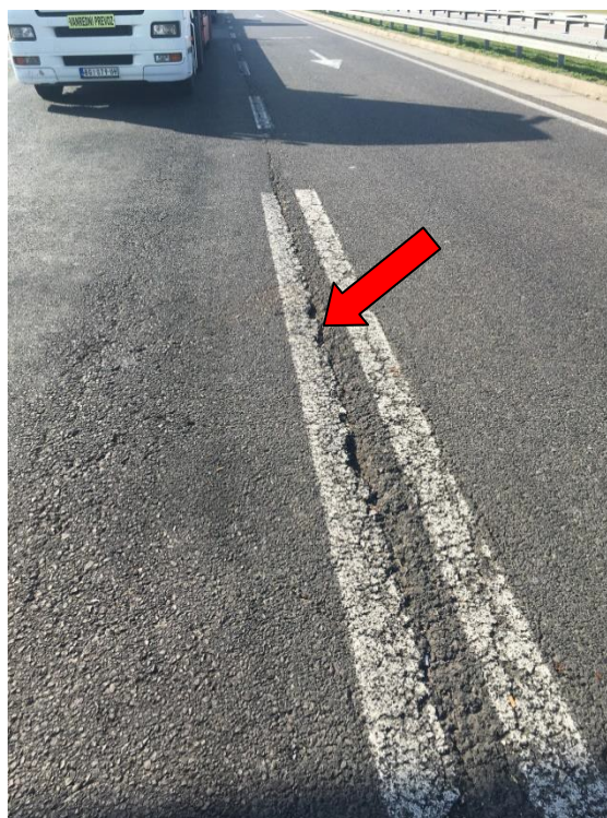
Слика 4.1.2. Подужни шлус између возне и претицајне траке
