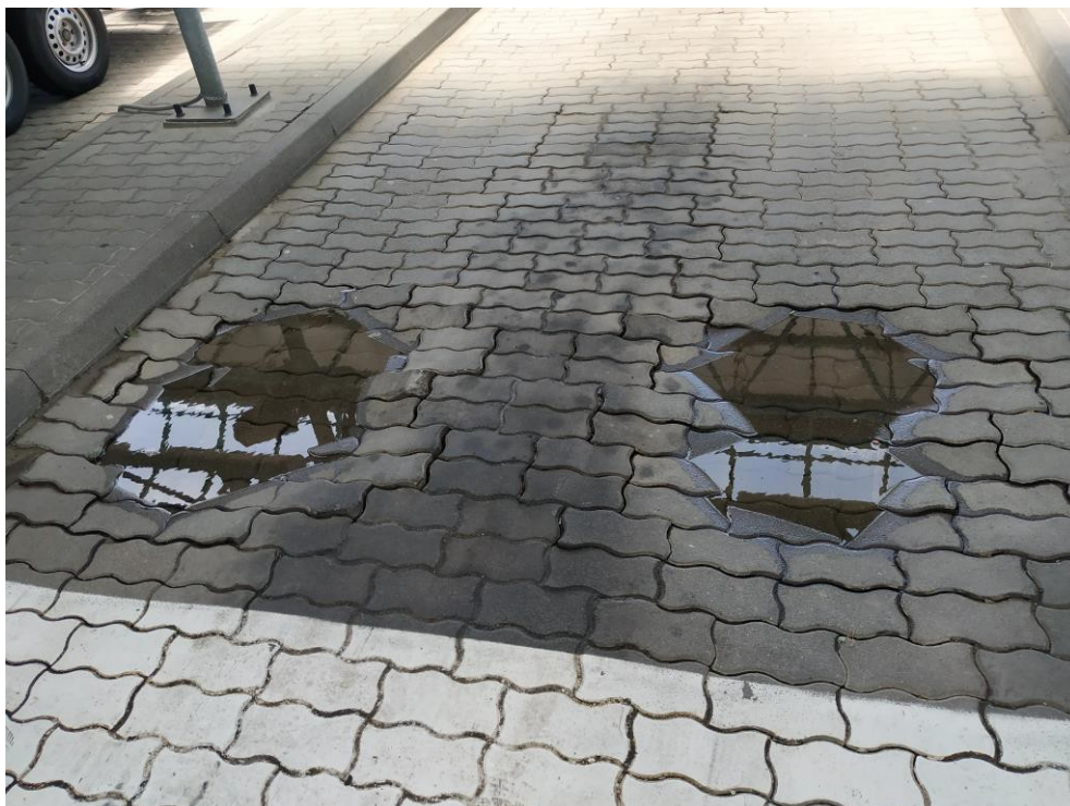
Слика 4.1.28. Улегнућа и колотрази на траци за путничка возила
