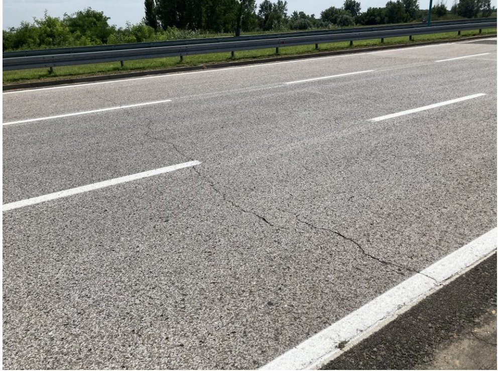
Слика 4.1.32. Попречна пукотина
