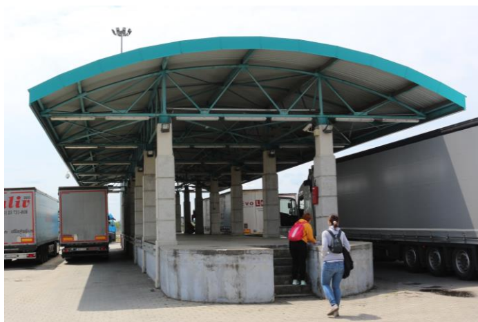
Надстрешница која се демонтира
